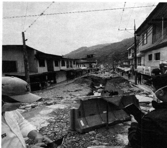
Visita de obra proyecto vías Gaitania-18/02/2022
