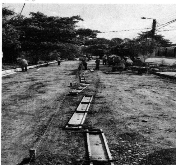
Visita de obra proyecto Álamos Mariquita-22/02/2022
