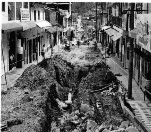
Visita de obra proyecto vías de Gaitania-18/02/2022
